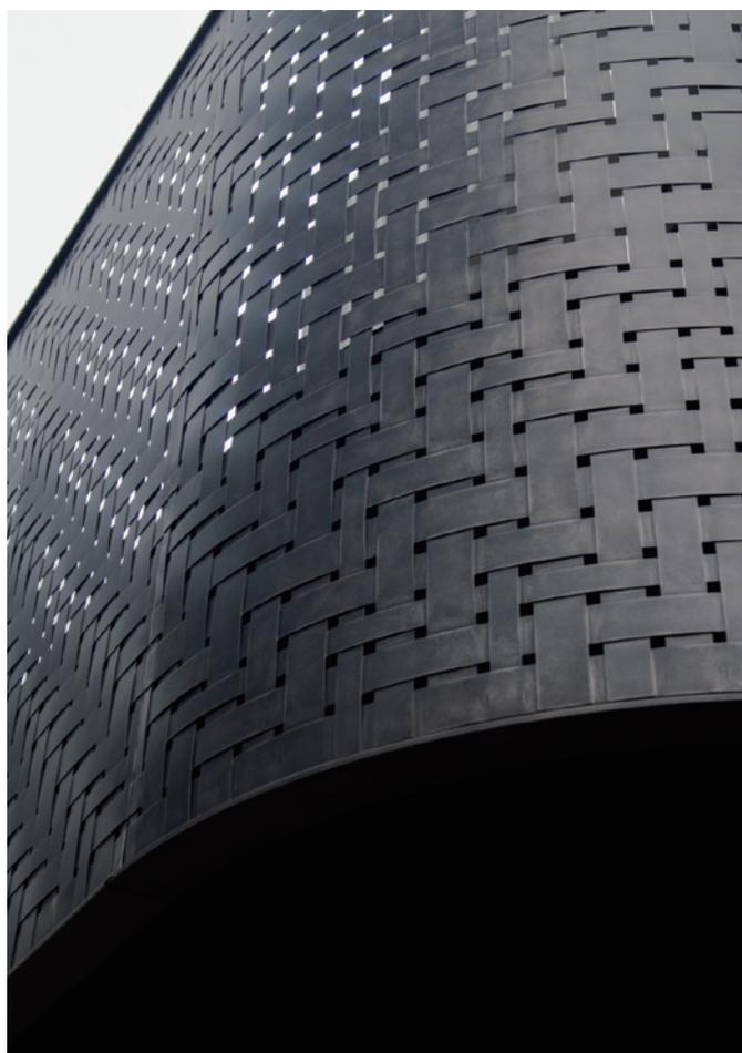
まるで編み物のような、格子状の複雑なデザイン。この斬新なアイデアは、金属材料としてステンレスを使用すること以外では実現し得ないものでした。折り重なったステンレス板の細かいところまですべて手作業で研磨し、デザイナーの納得いく表情まで繰り返し繰り返しサンプルを作成しました。複雑な編み込み、細部までこだわるカラーとテクスチャー。クラフトステンレスだからこそ出来上がった無二のパネルになっています。
