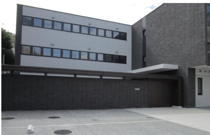
当初耐候性鋼の錆で計画していた案件ですが、庇の屋根も同じ仕上で行うことになり、より耐食性に優れた高耐食メッキ鋼板 ZCFC 仕上をご提案しました。屋根部材は雨仕舞やジョイント部納まり等、通常の数倍も気を使います。納まりに最大限配慮しながら、定評ある ZCFC-BR(ブラウン)を使用することにより安定感と統一感が断然増しています。
