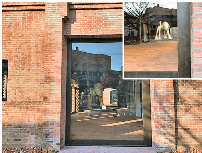
弘前れんが倉庫美術館（青森県）では、サッシと扉、イン ターホンパネルに「クラフト ステンレス」を採用
