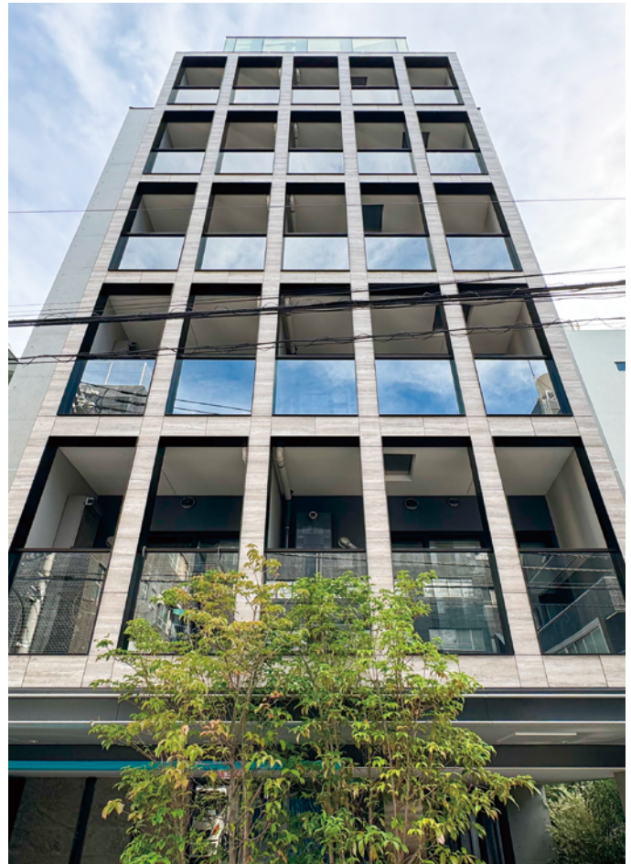
壁面から少し外に出る四方枠の薄さと、ガラス手摺の段差のない納まりに注目。
