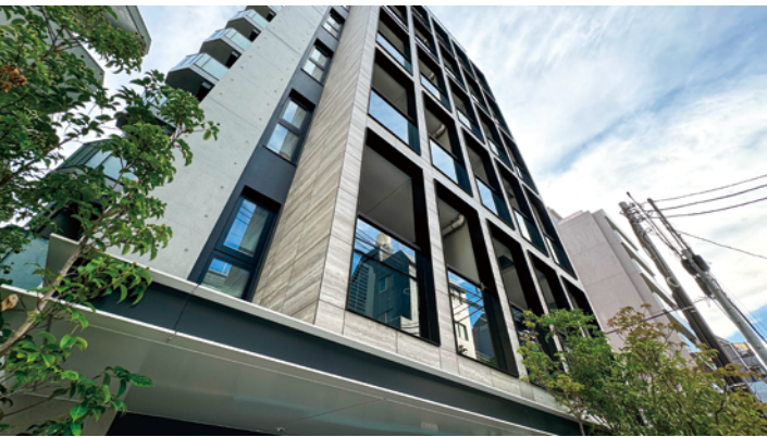
壁面から少し外に出る四方枠の薄さと、ガラス手摺の段差のない納まりに注目。
